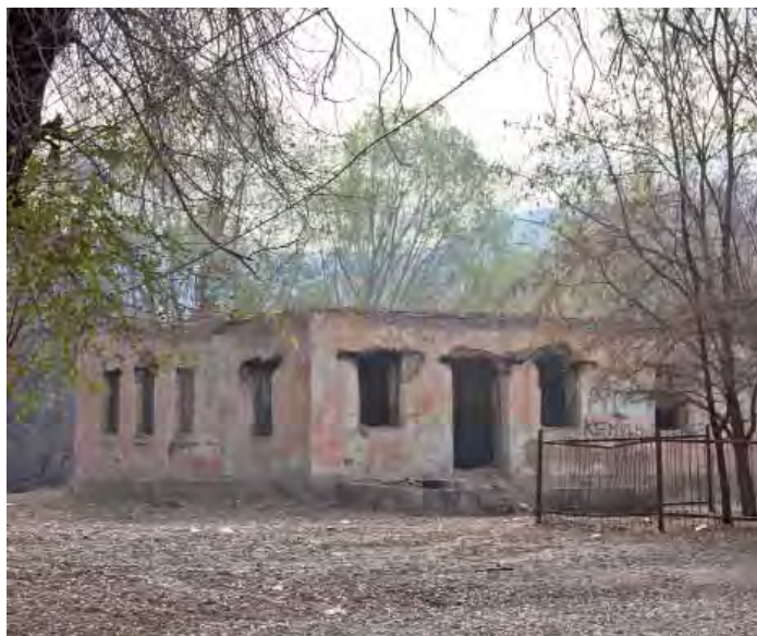
Гранитогоск. Разрушенное здание
